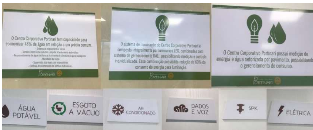
Figura 41. Placas que identificam as áreas técnicas e de serviços do empreendimento
