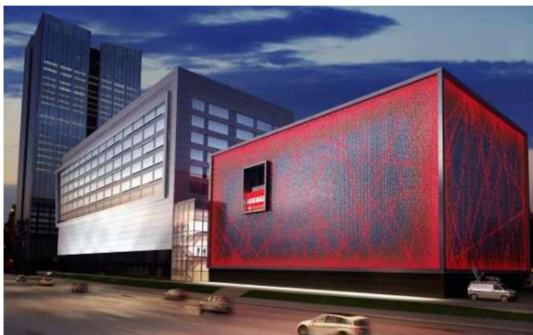
Figura 40. Fachada do Teatro Santander
